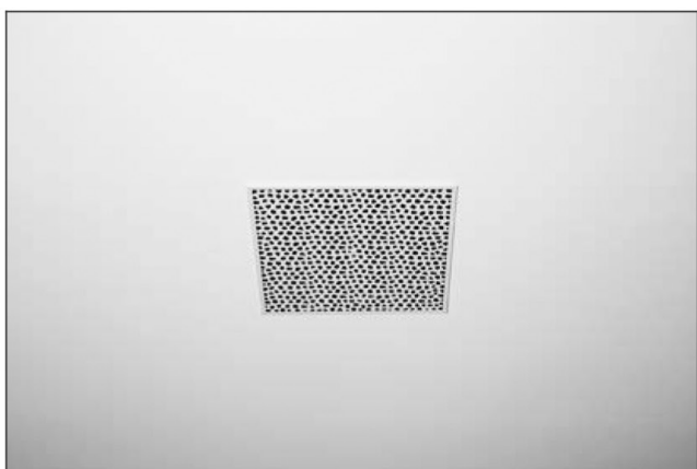
Vgradnja v zaprte stropne
