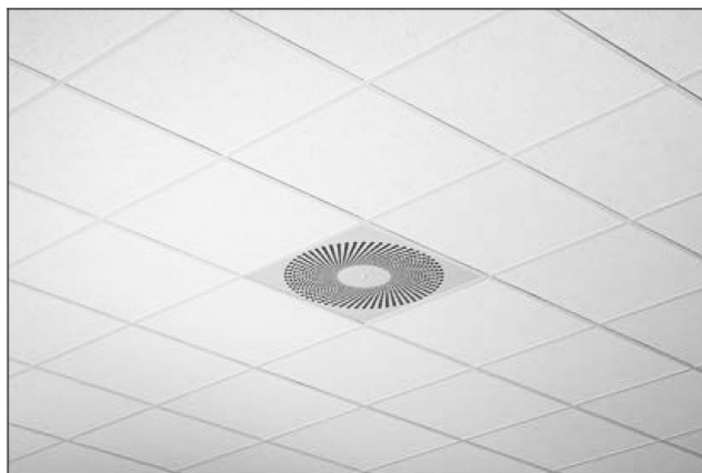
Vgradnja v spuščene stropne iz T profilov, razporejeno v vrsti
