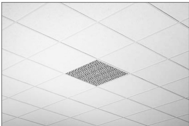
Vgradnja v spuščene stropne iz T profilov, razporejeno v vrsti
